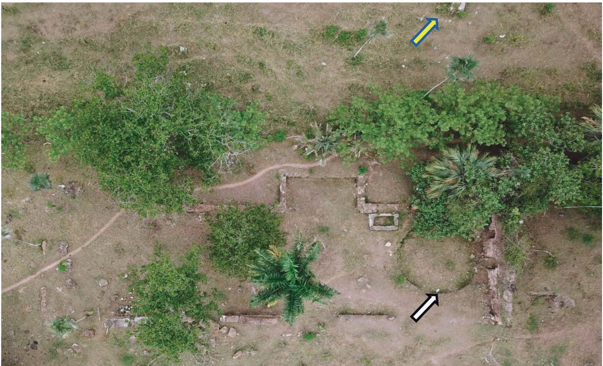
Figura 7.10. Vista aérea del edificio de molinero y calderas del ingenio de Sanate. Empleamos dos flechas para indicar espacios particulares en el esquema de producción. La flecha de color amarillo, en la parte superior de la imagen, precisa la ubicación de los restos de la acequia y su relación con la casa de calderas. La flecha de color blanco, en la parte inferior de la imagen, indica el espacio asignado al molino para generar la molienda con la caída de agua desde la acequia (Foto: Santiago Duval)
