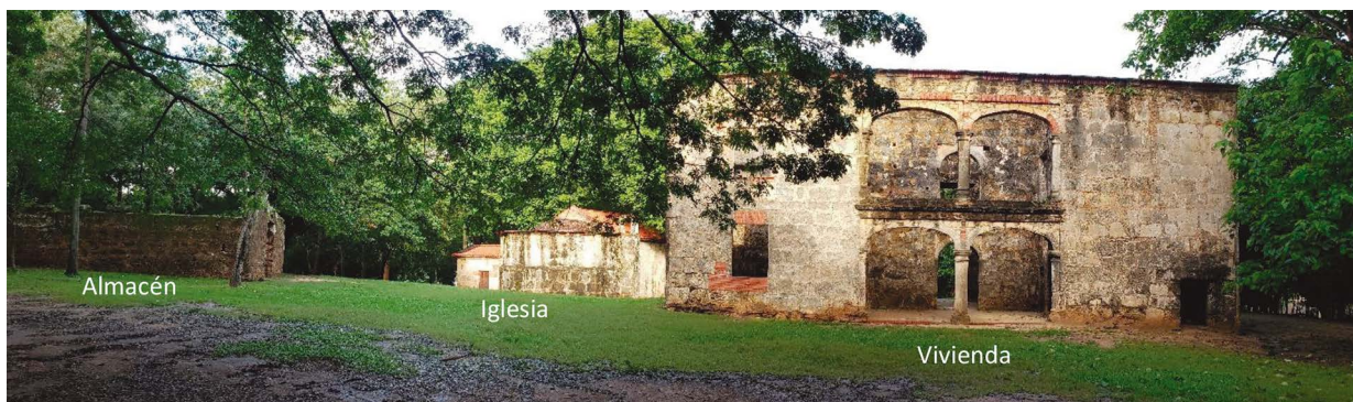
Figura 7.6. Panorámica que muestra el conjunto edificado compuesto por la vivienda del propietario, la iglesia y el almacén del ingenio de Engombe (Foto: Santiago Duval)
